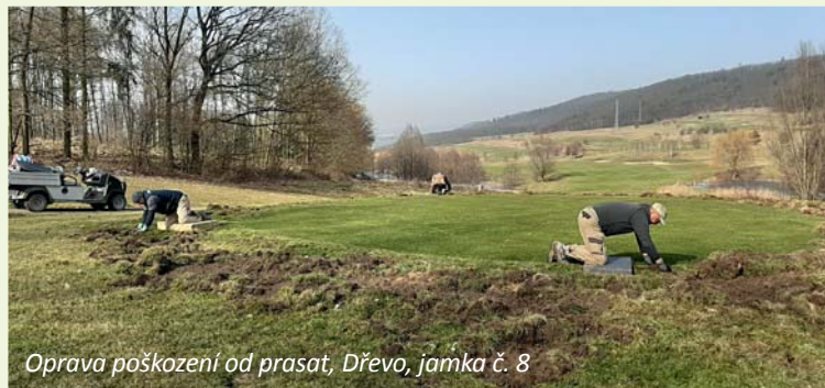
Budování cestičky Kámen, jamka č. 8-9
